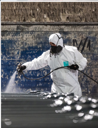
Lánchíd acélszerkezetek üzemi korrózióvédelme csarnokban
