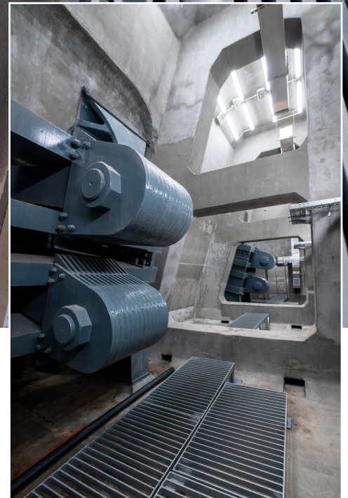
Lánchíd belső szerkezetének korrózióvédelme
